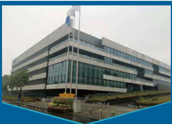
杭州某信息技术有限公司 (白色线条部分面板为花岗岩幕墙)
